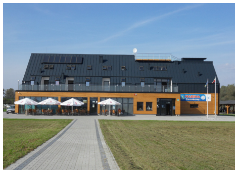
Ryc. 7. Budynek mariny. Fot. T. Mitura
